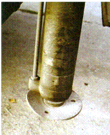
Abb. 126: Verbogener Stützfuß
