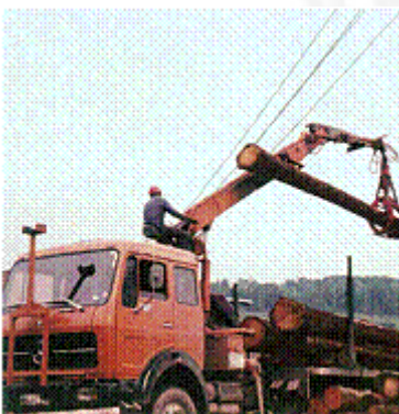
Abb. 179: Kranbetrieb in der Nähe elektrischer Freileitungen
