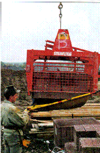
Abb. 177: Steingreifer mit zusätzlicher Sicherung gegen Lastabsturz
