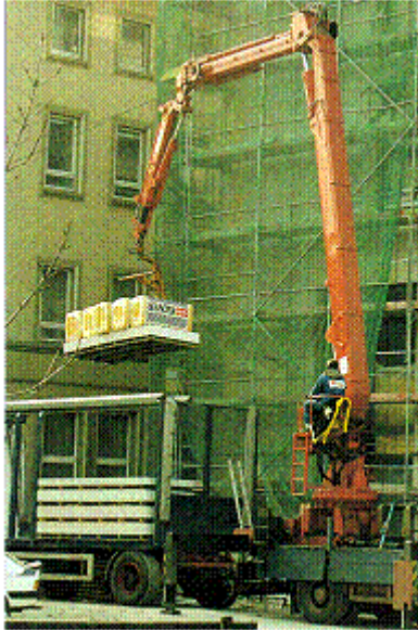
Abb. 196: Nicht bestimmungsgemäßes Verwenden, da Wendegabel nicht geschlossen
