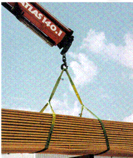
Abb. 239: Last sicher angeschlagen
