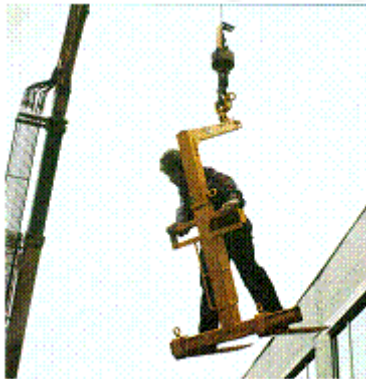
Abb. 182: Verbotene Personenbeförderung mit Lastaufnahmemittel
