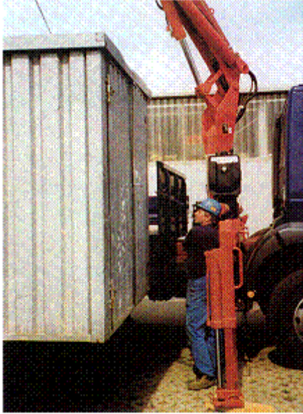
Abb. 66: Fluchtweg versperrt – Steuerstand wird zur "Mausefalle"
