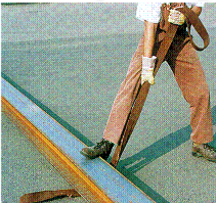
Abb. 211: Verbotenes Hervorziehen von Hebebändern unter aufliegenden Lasten
