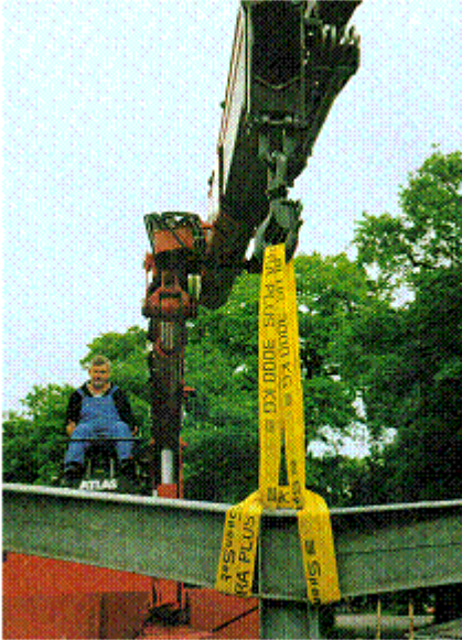
Abb. 206: Rundschlinge als Anschlagmittel
