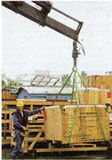
Abb. 87: Steuern des Krans mittels Funkfernsteuerung
