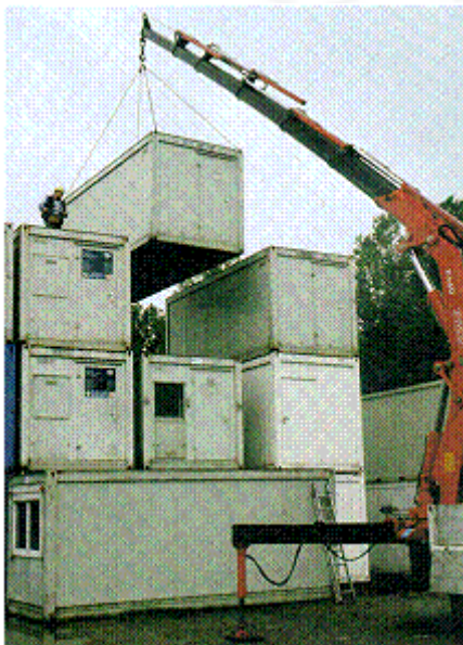
Abb. 251: Anschlag von Bürocontainern entsprechend Angaben des Containerherstellers
