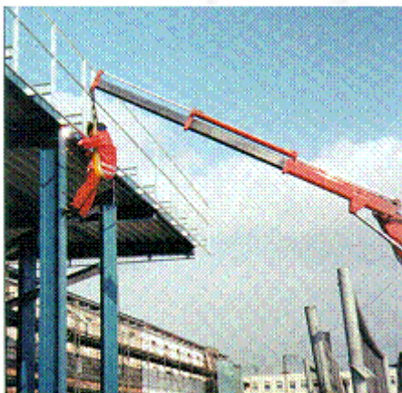
Abb. 184: Anschlagmittel sind keine geeigneten Personenaufnahmemittel
