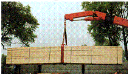
Abb. 245: Verbotenes Anschlagen mit Einzelschlinge
