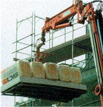
Abb. 250: Unzulässiges Heben einer Last bestehend aus losen Einzellasten
