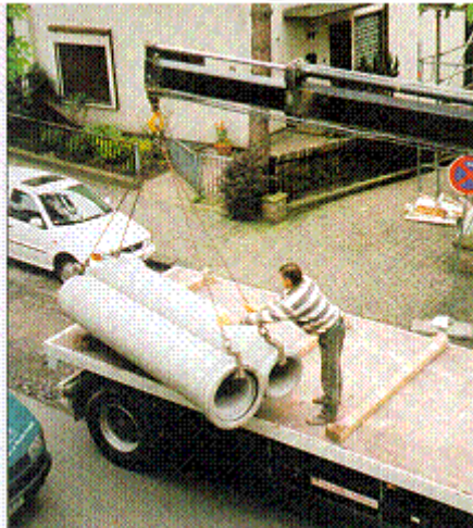
Abb. 234: Anhängen der Last am Lasthaken mit Hilfe von Anschlagmitteln
