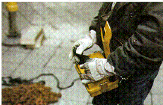
Abb. 88: Funkfernsteuerung des Ladekranes im Einsatz
